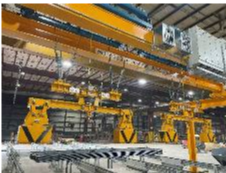
Bild 7: Nach der Auslagerung übernimmt der Brückenkran mit Magnettraverse die gebündelten Stäbe.
